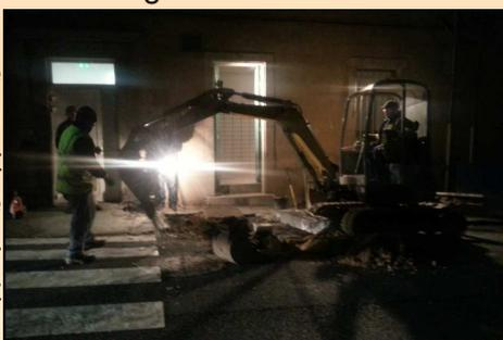
Sous le pilotage de l'Architecte de l'établissement, GRDF a été contacté rapidement pour trouver avec eux une issue. Il a été convenu de déplacer le compteur pour "shunter" la partie percée. En effet, l'alimentation en gaz de la Résidence ne se justifiait plus du fait de l'enlèvement de la chaufferie de ce bâtiment.
